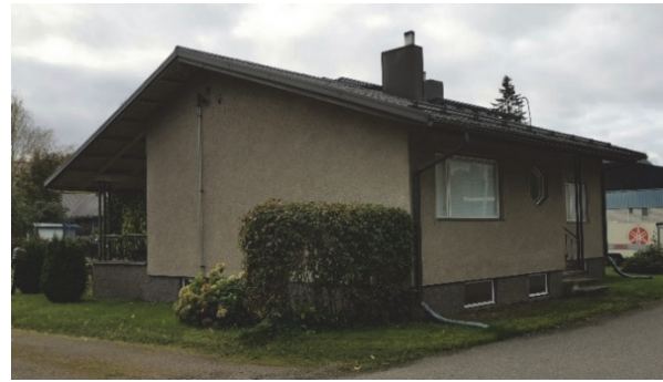
Kuva 8. Pääosa rakennuksista on rapattu.
