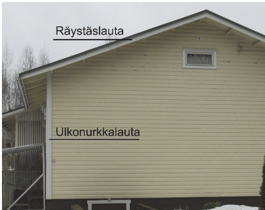
Kuva 27. Ulkonurkka- ja räystäslaudat maalattiin joko muun julkisivun väriin tai tehostevärillä. (kuva: Arkkitehtuuritoimisto Arkhaltia Oy)
