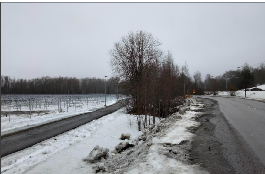
Kuva 29. Rakenteilla oleva Helen Oy:n paneelialue Lohjalla. Tien ja paneelialueen välissä oleva puusto peittää näkymiä paneelialueelle. (Kuva: FCG, Ida Tammi)
