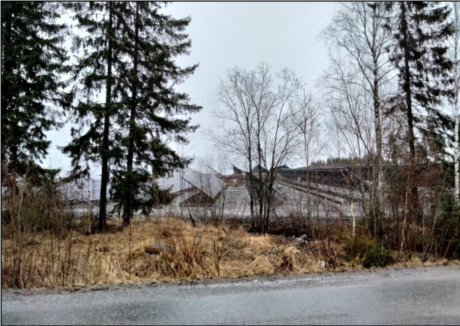
Kuva 26. Pienikin kasvillisuusvyöhyke paneelialueen ja katselupisteen välissä vähentää aurinkopaneelien maisemavaikutusta. Havupuut toimivat näköesteenä myös talvisin. Rakenteilla oleva aurinkovoima-alue Rauman Lakarissa. (Kuva: FCG, Ida Tammi)
