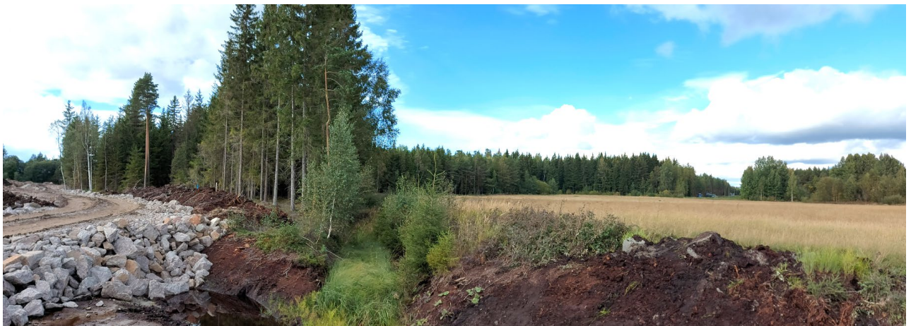
Kuva 4. Näkymä rakenteilla olevalta Kultasuontieltä kohti pohjoista Kullasvaara 3:n asemakaavoitettavalle alueelle.
