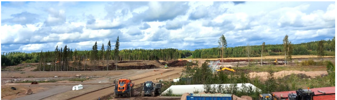
Kuva 3. Näkymä rakenteilla olevan intermodaalialueen pohjoisosasta kohti pohjoista. Kullasvaara 3 asemakaavan suunnittelualueita ovat rakennustyömaan takana näkyvät pellot ja metsät.
