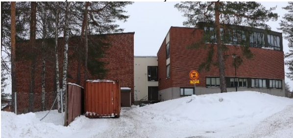
Kuva 5. Näkymä lännestä rakennuksen huoltosisäänkäynnille.
