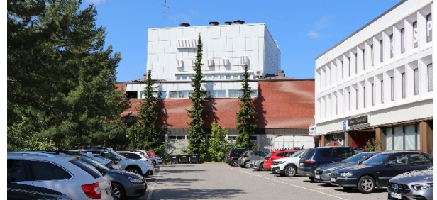
Kuva 10. Näkymä teatterille idän suunnalta.
