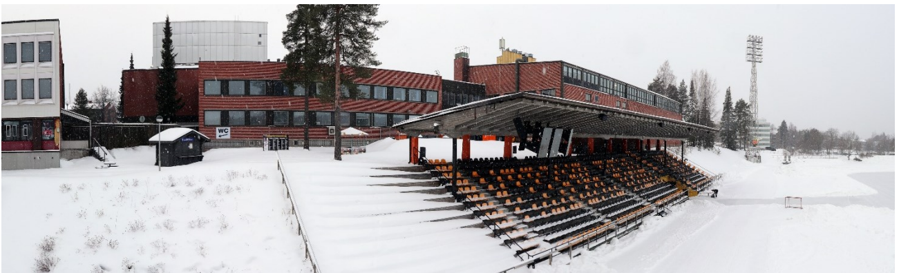
Kuva 16. Näkymä suunnittelualueelle pohjoisesta. Etualalla kaavamuutosalueella sijaitseva pesäpallostadionin katos.
