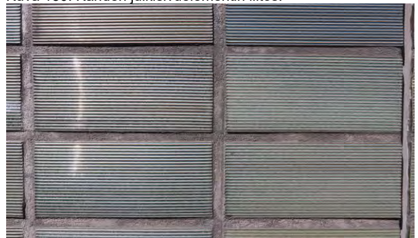
Kuva 131. Rakennuksen julkisivupinnan laatoitusta.
