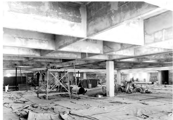
Kuva 49. Kirjaston sisätilä ja vesikaton betonipalkit.
