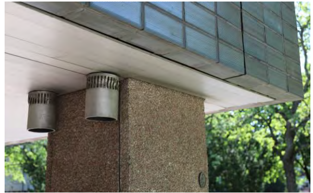
Kuva 129. Arkadikäytävän katoksen liitos.
