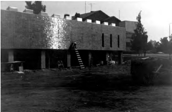
Kuva 50. Kirjaston julkisivujen laatoituksen saumaustyö 1971.
