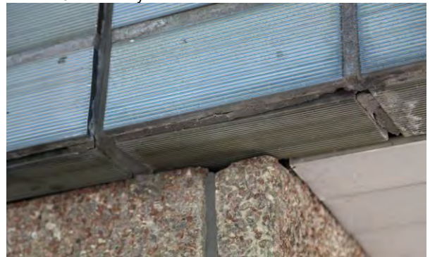
Kuva 130. Kahden julkisivuelementin liitos.
