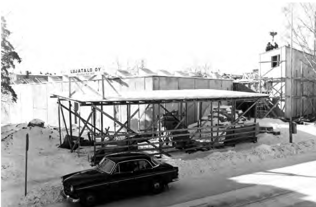
Kuva 48. Kirjaston rakennustyöt etenevät kevättalvella 1971.
