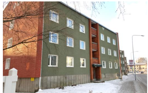
Kuva 5. Rakennus kuvattuna Salpausselänkadulta lännen suuntaan.
