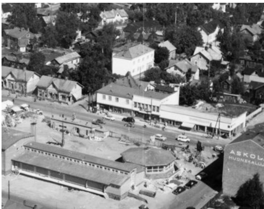
Kuva 4. Kauppahalli ja sen ympäristö noin vuonna 1956 ennen Pukimon talon rakennustöiden aloitusta. Korttelissa 1093 ja nykyisen Hansatorin kohdalla oli tuolloin pääasiassa puurakenteisia pientaloja ja matalia liikerakennuksia.
