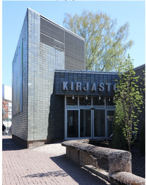
Kuva 76. Kirjaston sisäänkäynnin yhteydessä oleva tornimainen osa sisältää asiakkaiden wc-tilojen lisäksi rakennuksen IV-konehuoneen. Rakennusta kiertävät pesubetoniset kaitteet ovat alkuperäiset. Seinän vieressä olevat istutuslaatikot ja niiden istutukset on uusittu vuonna 2022.
