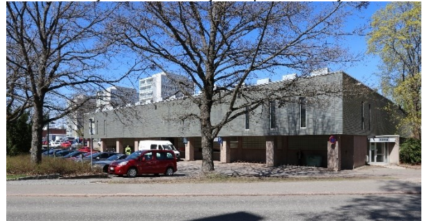
Kuva 67. Kirjaston eteläjulkisivu Oikokadun suuntaan.
