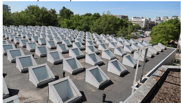
Kuva 68. Näkymä kirjaston katolta, jossa on 256 kattoikkunaa.
