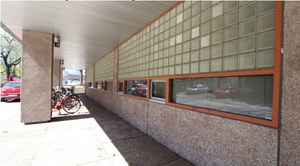
Kuva 63. Kirjasto eteläjulkisivun ikkunapintaa.
