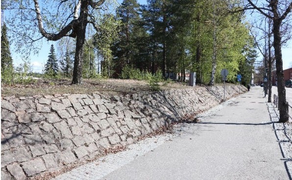
Kuva 73. Salpausselänkadun pohjoisreunassa olevan graniittikiviuiskan yläpinta kuvaa historiatietojen mukaan Kouvolan keskusta-alueen alkuperäistä maanpinnan tasoa.
