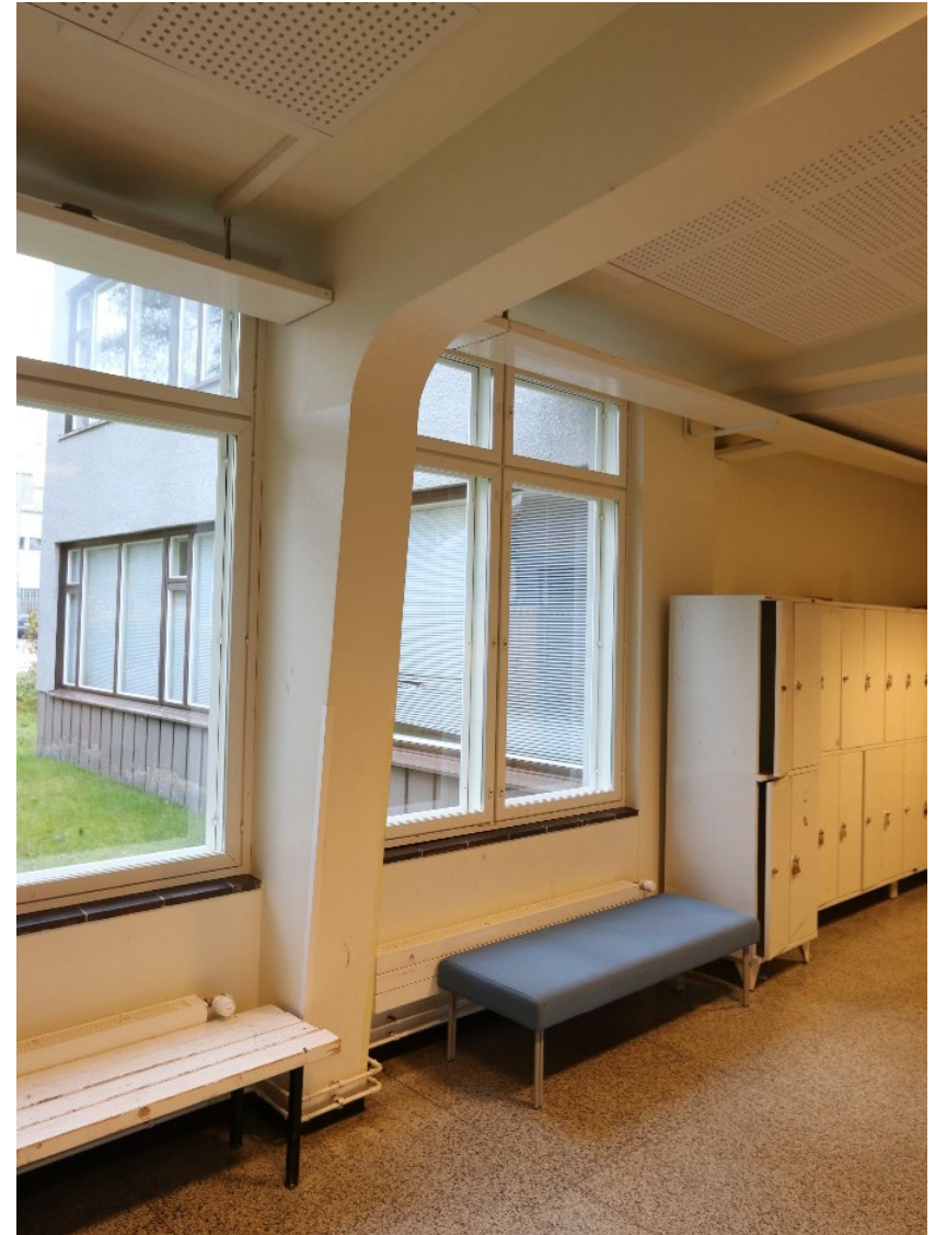
Eteishallissa on esillä pilarien ja palkkien muodostamat kehät. (HP)
