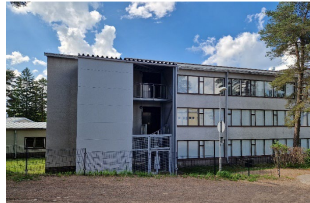
Poistumistieportaassa on osittain avonainen ja osittain umpinainen peltijulkisivu. (AV)
