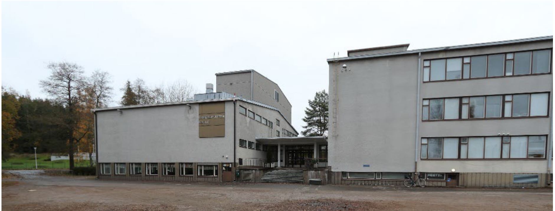
Korkeammassa luokkahuonesiivessä on nauhaikkunat. Liikuntasaliosan julkisivu on pihan suuntaan umpinainen. Korkea sokkeli, johon sijoittuvat ruokalan ikkunat, toimii sen jalustana. (HP)
