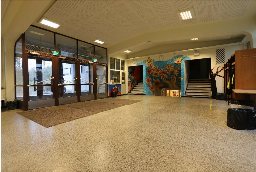
Eteishallin lattia on mosaiikkibetoniruutua. (HP)
