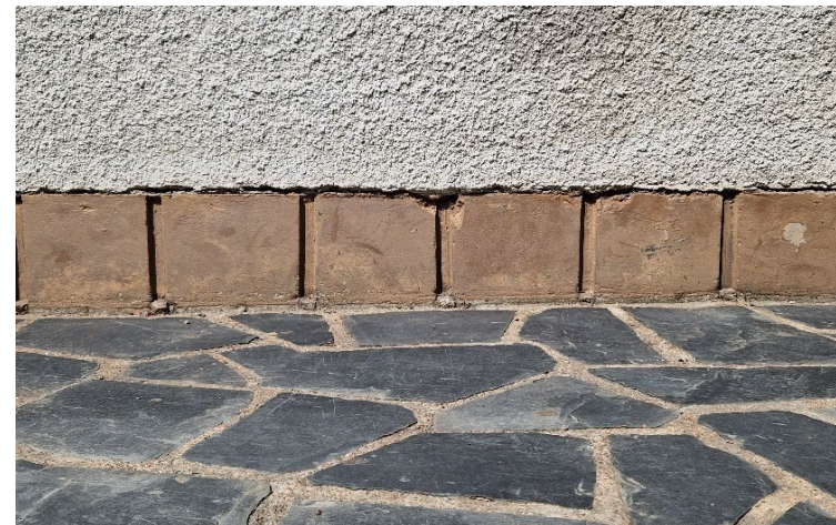
Roiskerappausta, sokkeli ruskeaksi maalattua uritettua betonia ja sisäänkäyntiterassin liuskekipintaa. (AV)
