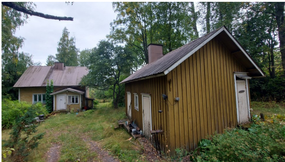
Kuva 13. Kaava-alueella oleva rakennuspaikka.
