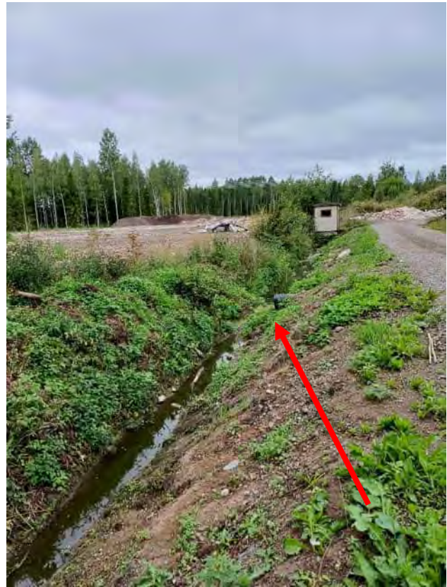
Kuva 3. Eteläinen ympärysoja ja rumpu
