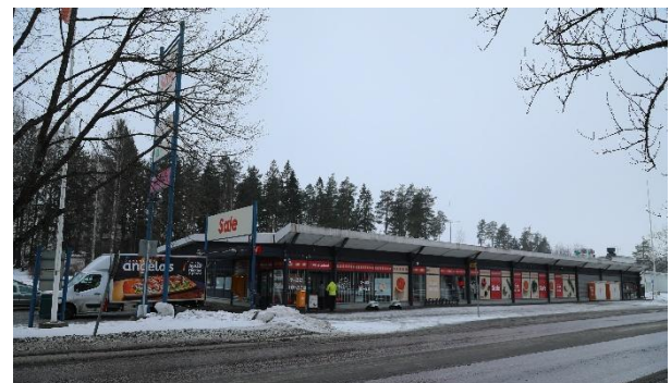
Kuva 4. Liikerakennus pohjoisesta Tasankotien suunnasta.
