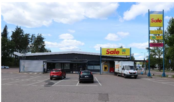
Kuva 3. Eskolanmäen liikerakennus idästä. Piha-alueella on aiemmin sijainnut polttoaineen jakeluasema.
