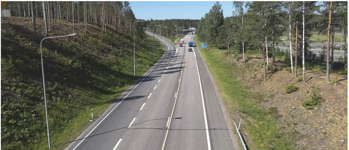
Kuva 2. Suunnittelualueen eteläosassa valtatie kulkee pääosin maaleikkauksessa. Valtateiden risteyskohdassa tiet ovat kuitenkin virkistysaluetta korkeammalla ja melu pääsee etenemään esteettömästi.
