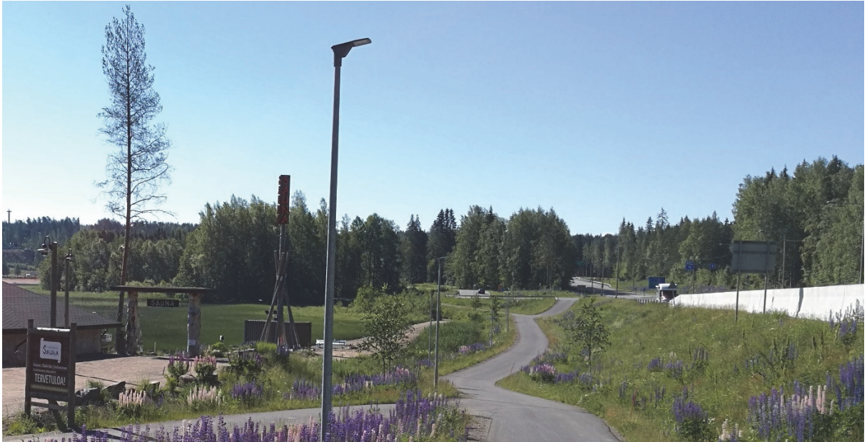
Kuva 1. Tykkimäen saunan kohdalla valtatie reunassa on melukaide noin 130 m matkalla. Melukaide ei kuitenkaan ulotu koko sille matkalle, jolla vesialue on lähellä valtatieä, jolloin melu kantautuu Käyrälammen pohjoisrannalle saakka.
