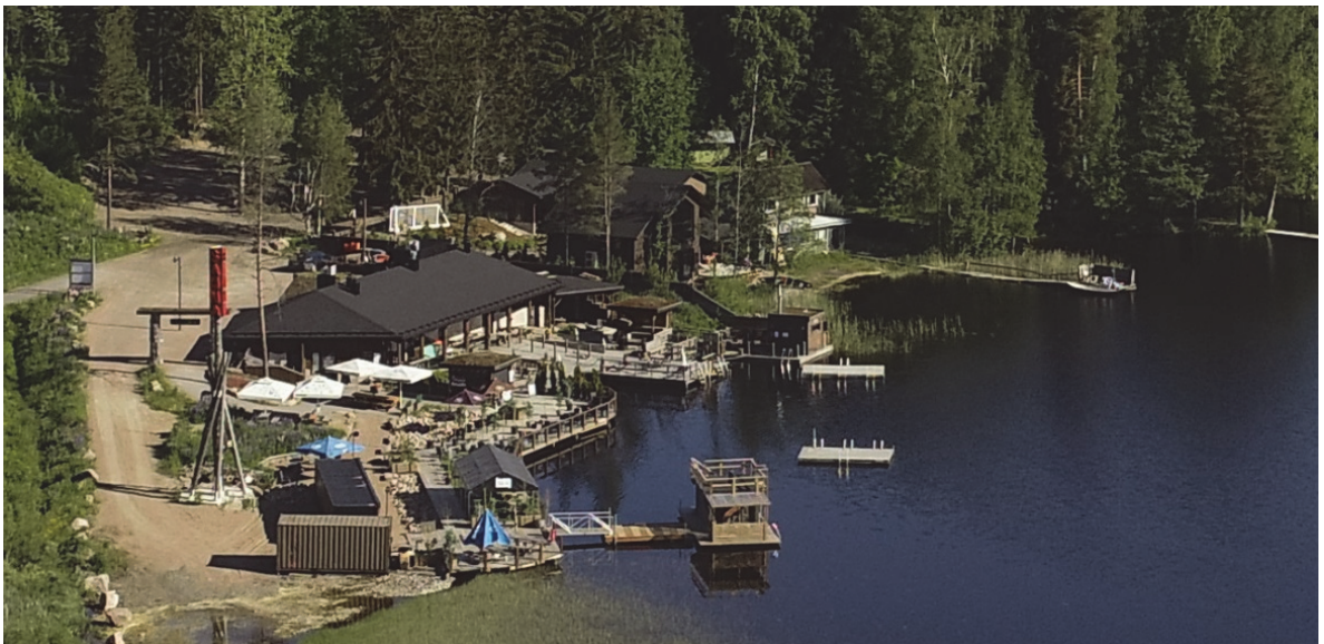
Kuva 7. Tykkimäen Sauna valmistui vuonna 2017 ja sen pohjoispuolella oleva kokousrakennus vuonna 2020. Tontilla sijaitsee lisäksi talousrakennus ja vanha 1951 valmistunut asuinrakennus. Niiden pohjoispuolella on yhdistyksen käytössä oleva sauna-/lomarakennus ja yksityisessä omistuksessa oleva rantsauna.
