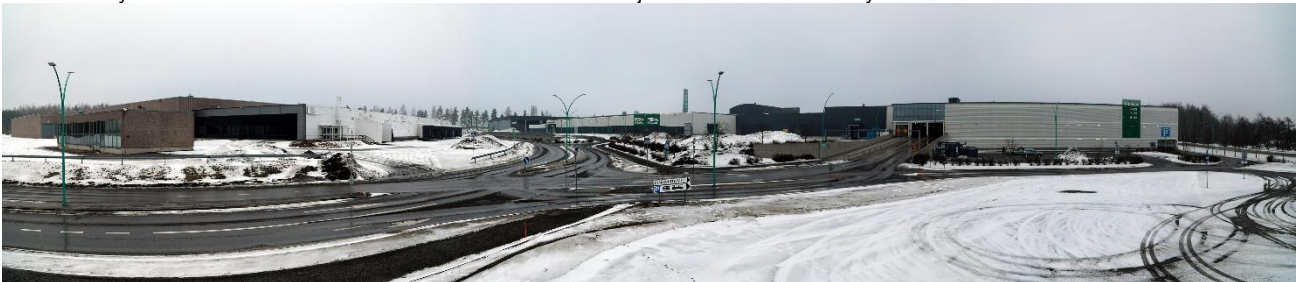
Kuva 7. Näkymä suunnittelualueelle idästä Tommolankadulta helmikuussa 2025. Kuvan vasemmassa laidassa on Plus Logisticin hallirakennus, keskellä KSO:n rakentajan noutopiha ja puutarhamyymälä. Kuvan oikeassa reunassa on prismakeskuksen paikoitushalli.
